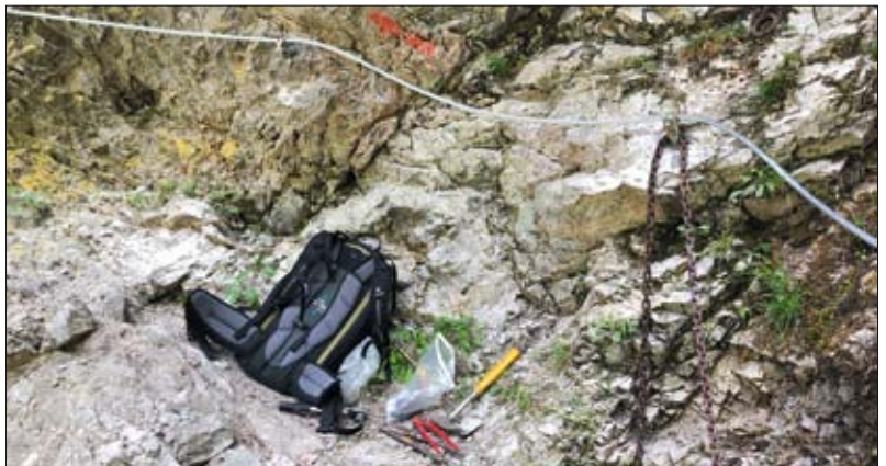
Mit großem Aufwand an Werkzeug und Material wurde der Steig durch das Krottental wieder instand gesetzt. (Foto G. Baumann)
