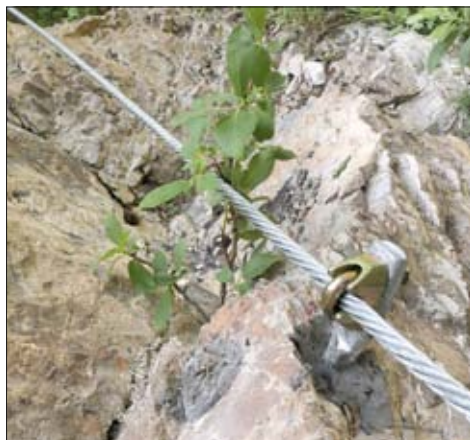
Neuer Anker mit dem 12 mm Stahlseil (Foto G. Baumann)
