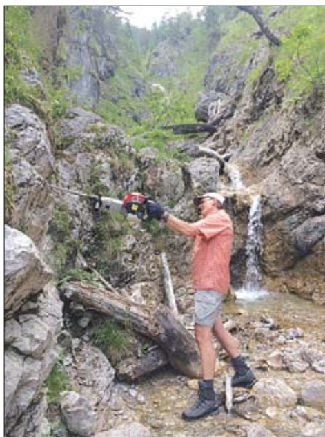
Willi beim Bohren für die neuen Anker (Foto G. Baumann)
