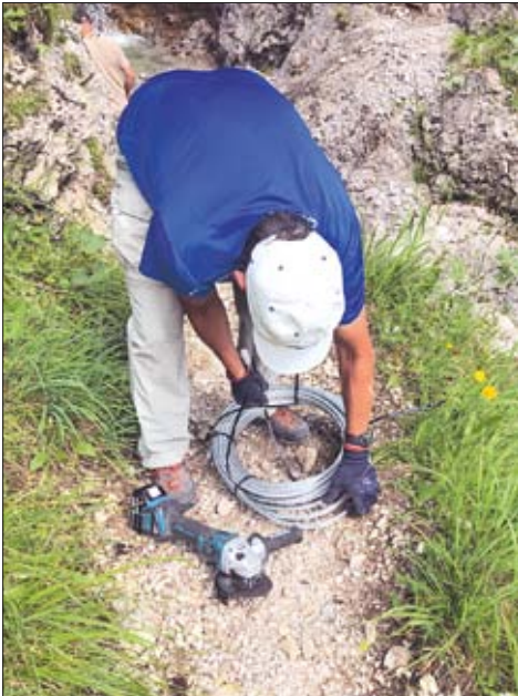
Bereitstellen des Materials (Foto G. Baumann)
