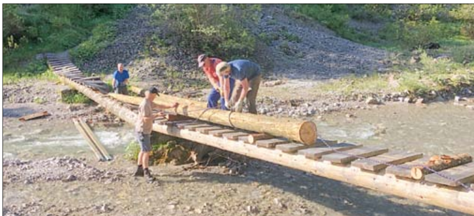
Der Wiederaufbau der Brücke, eine harte Arbeit (Foto G. Baumann)
