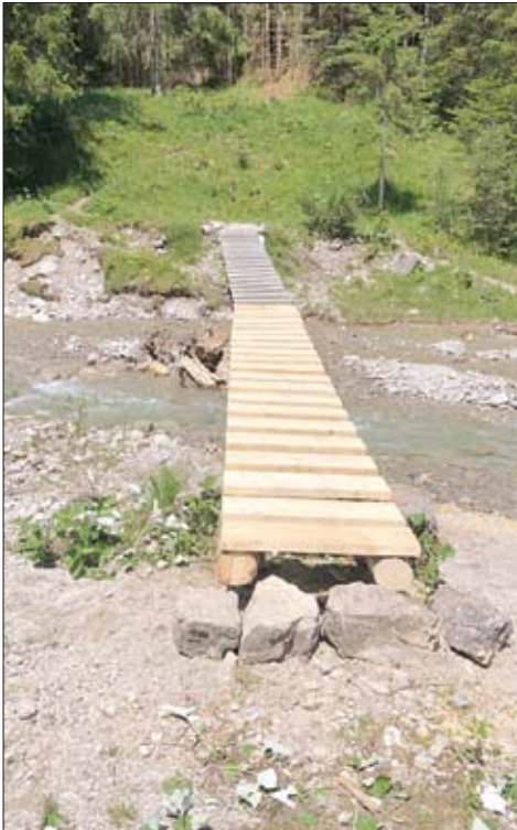
Überqueren des Weißenbaches wieder möglich (Foto G. B.)
