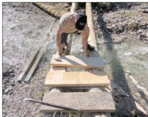
Anbringen des neuen Brückenbelages (Foto G. Baumann)
