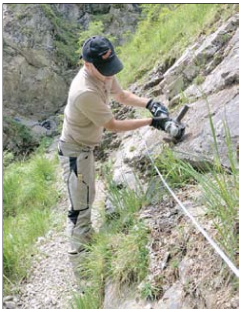
Abflexen der alten Verankerungen (Foto G. Baumann)
